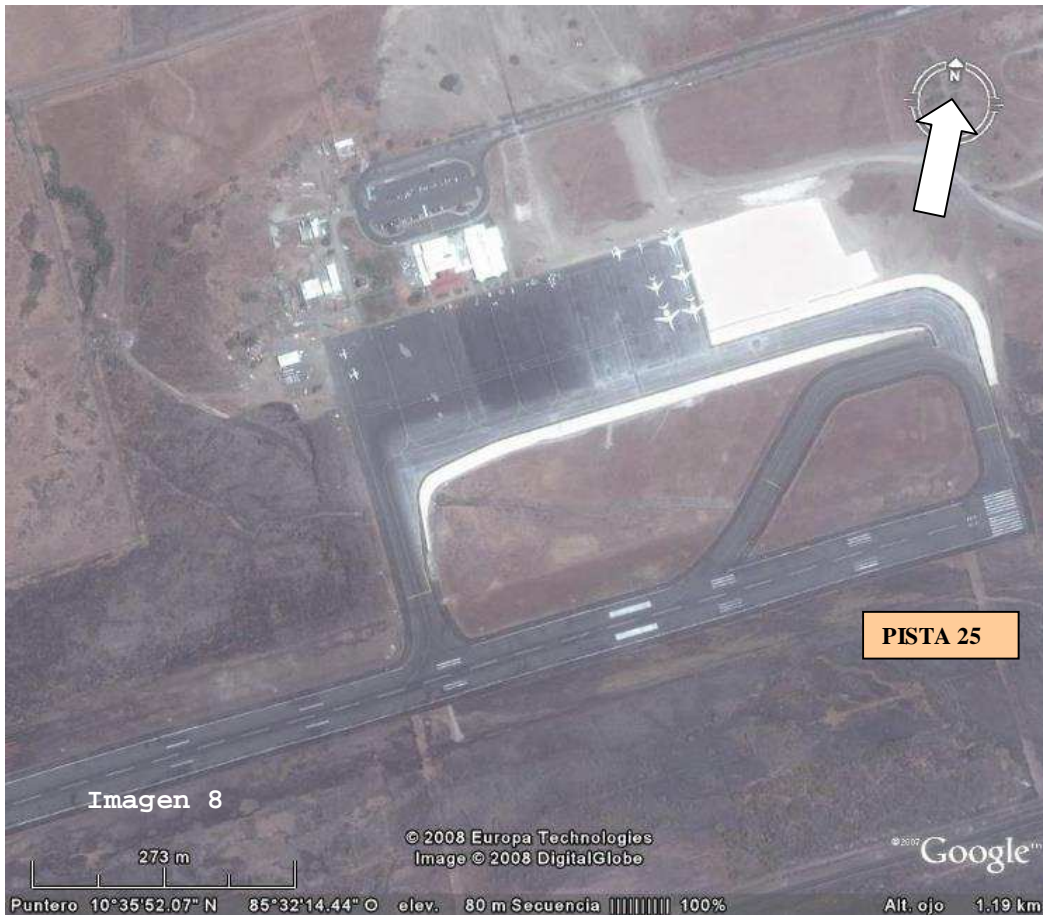
Imagen 8 Vista aérea de la pista "25", en el sector noreste del Aeropuerto Internacional Daniel Oduber Quirós. La flecha indica el Norte.
