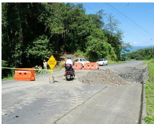
Ruta Cambronero obstruida. (Fuente La Nación)
